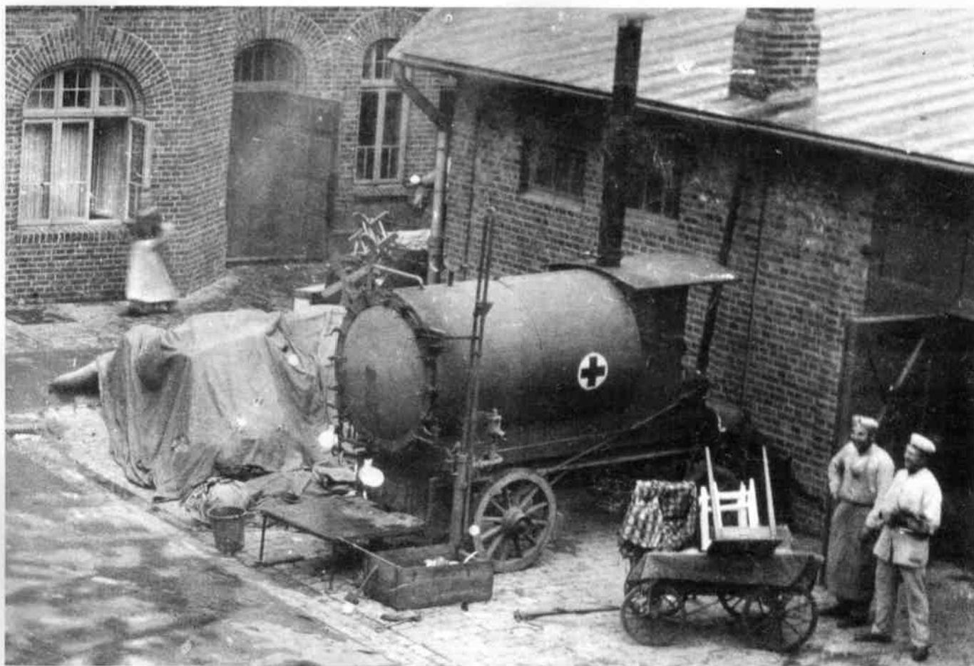
Gestempelt von einer Kaiserlichen Kriegslazarettabteilung am 27. Juli 1915, zeigt dieses Foto einen dampferzeugenden Entlausungsöfen für Pferdebespannung, der fast die Ausmaße einer Lokomotive hat.
