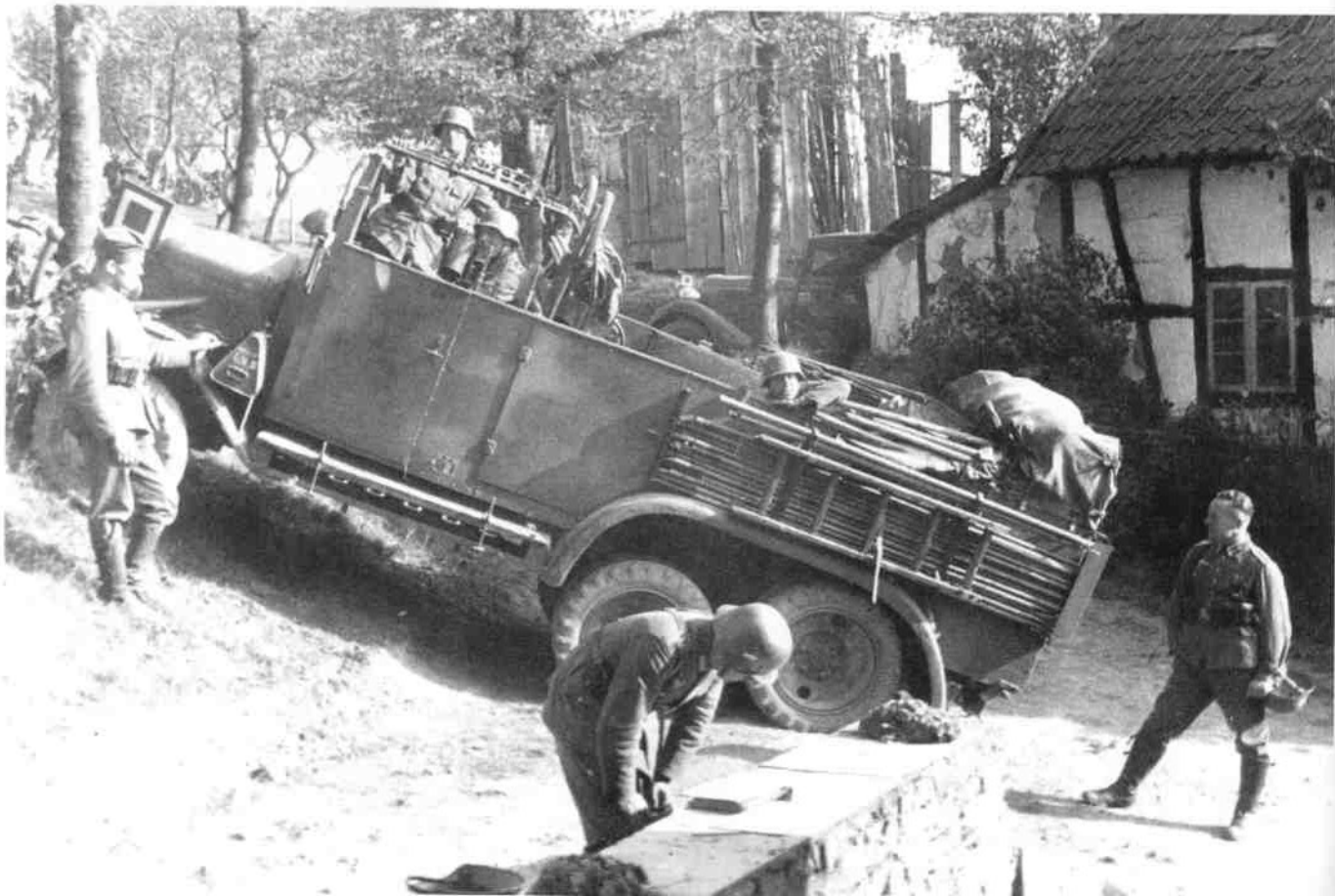
Aufgenommen in den 1930er Jahren: Ein Fernsprech-Kraftwagen Kfz. 77 auf G 31 im Manöver. Das Fahrzeug gehörte zum I. Zug der Nachrichtenabteilung der 15. Infanterie-Division aus Frankfurt am Main. Pictured in the 1930s, a Fernsprech-Kraftwagen Kfz. 77 signals truck on Büssing NAG G 31 chassis during an exercise. The vehicle belongs to 1st platoon of the signals and communications unit of the 15th infantry division from Frankfurt, Germany.
