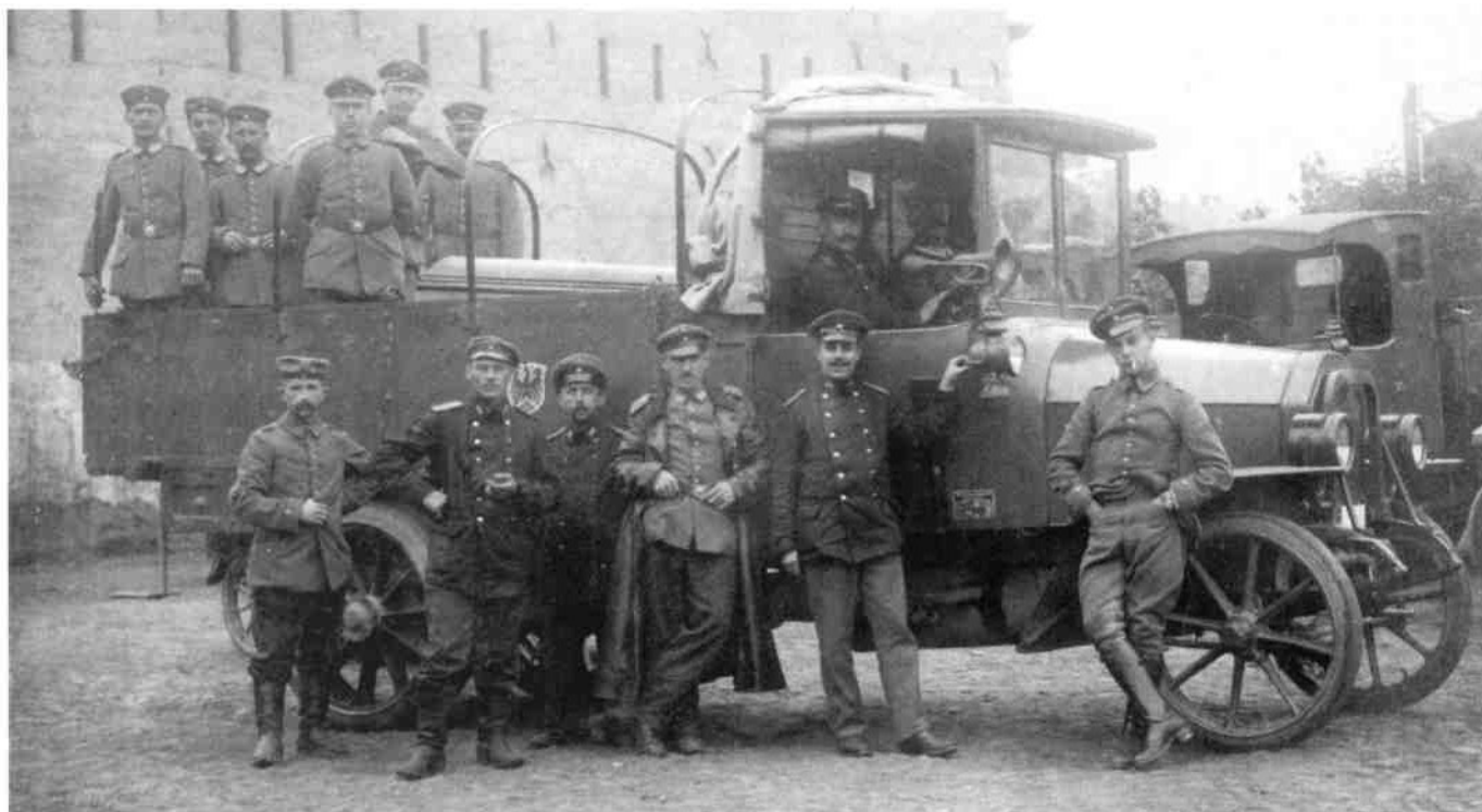
Beide Bilder auf dieser Seite zeigen den gleichen Typ, nämlich 3 to-Kardan-Lastwagen vom Typ DC 3 cl, gebaut zwischen 1915 und 1917 von Daimler Marienfelde. Während der oben abgebildete Wagen, einem Beerdigungskommando dienend, nagelneu erscheint, zeigt der untere, fotografiert im Juni 1917 in Cüstrin/Neustadt, schon einige Abnutzungserscheinungen. Both pictures on this page show the same 3-ton Kardan-Lastwagen Typ DC 3 cl, manufactured from 1915 to 1917 by Daimler Marienfelde. While the truck above belongs to a burial unit and is obviously brand new, the truck below, pictured in June of 1917 in Cüstrin/Neustadt, already shows some wear and tear. (HH)
